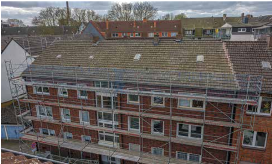
Ein Beispiel für die kontinuierlichen Investitionen konnte unlängst gegenüber des GEWOGÉ Büros an der Jahnstraße in Laar beobachtet werden. Das Haus Jahnstraße 33 bekam einen neuen Dachstuhl.
