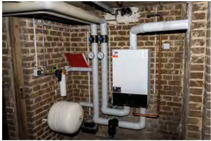
Die Heizungsanlagen in den Gebäuden der GEWOGE sind in den vergangenen Jahren ausgetauscht worden. Dabei ist dieser Prozess nicht abgeschlossen, denn je nach Alter der Anlage passiert dies auch weiterhin. Dabei ist festzustellen, dass die neuen Geräte meist deutlich kleiner sind als die älteren Anlagen, wie unsere Fotos zeigen.
