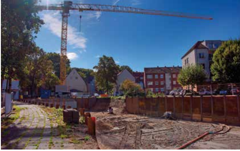
Der große Baustellenkran ist inzwischen auch schon aufgestellt worden.
