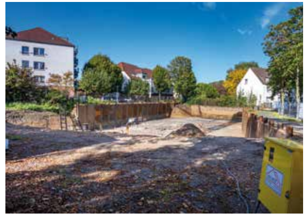
Wer von der Jahnstraße entlang der Friesenstraße in die Baugrube blickt, kann erahnen, dass hier ein größeres Gebäude errichtet wird.
