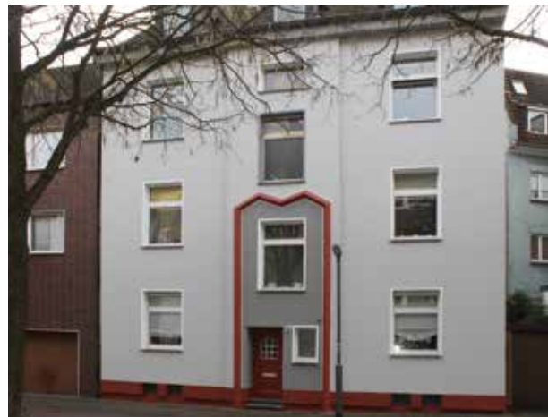
Das Objekt Werthstraße 79 ist ein Hingucker.
